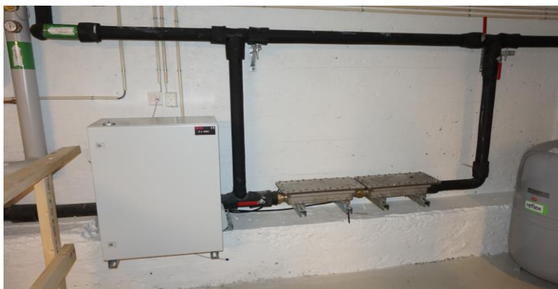
Eksempel på installasjon med Apurgo M3-25
